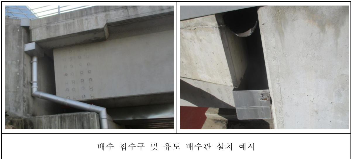
<그림 6.3.14> 신축이음하면 유도 배수관 설치
